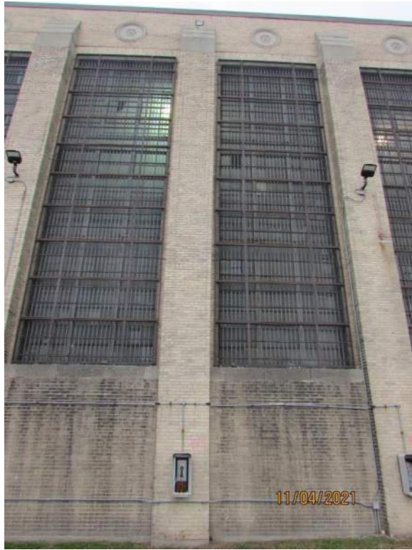
Fig. 3a Pier W3
