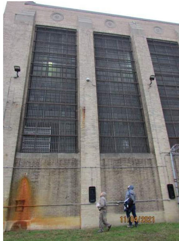
Fig. 3d Pier E2
